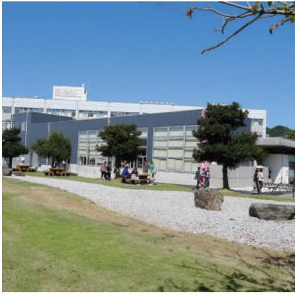
増改築した第一学生食堂 ポーノ
